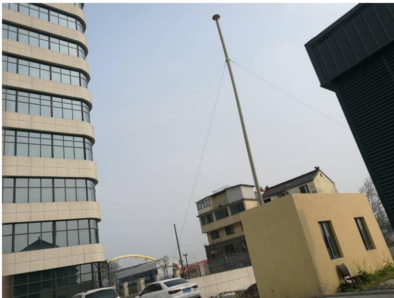
图 4-3 污水站废气排气筒照片
