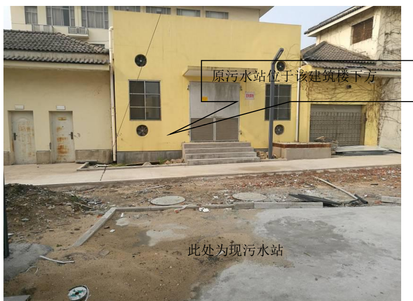
图 4-6 环境风险（事故应急池）应急设施图片
